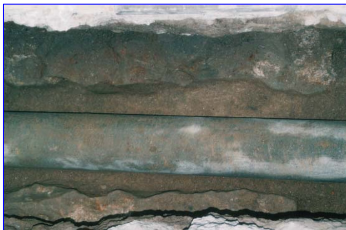
Làmina 5: Imatge del mur U.E 104. nº inventari:118/03-6
